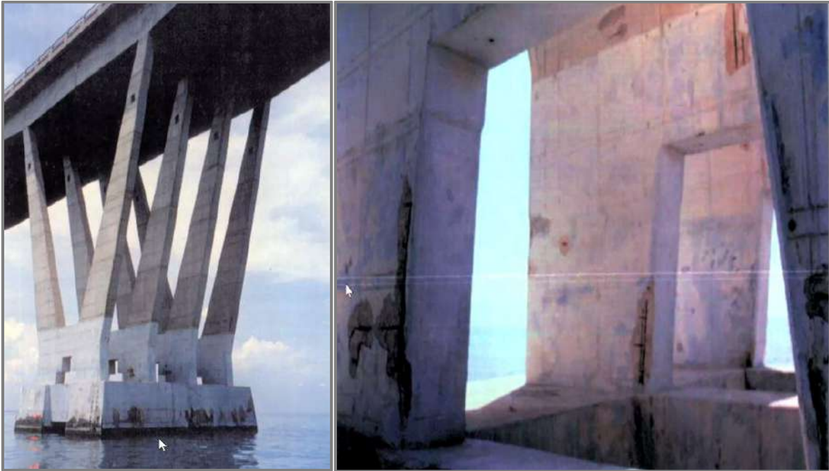
Imagen N° 34. Pila 9 del PGRU e Imagen N° 35. Pila 10 del PGRU
