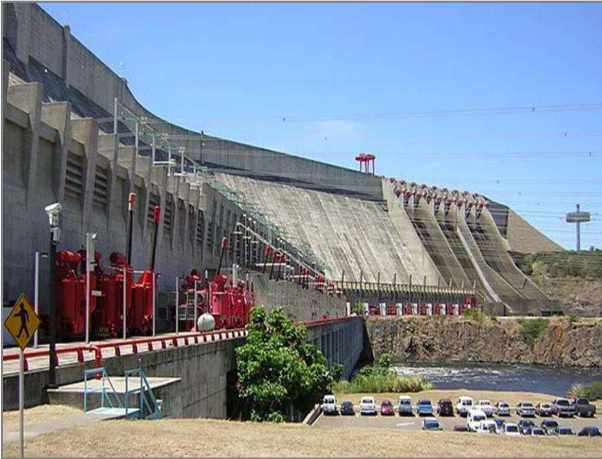
Imagen N° 4. Central Hidroeléctrica Simón Bolívar
