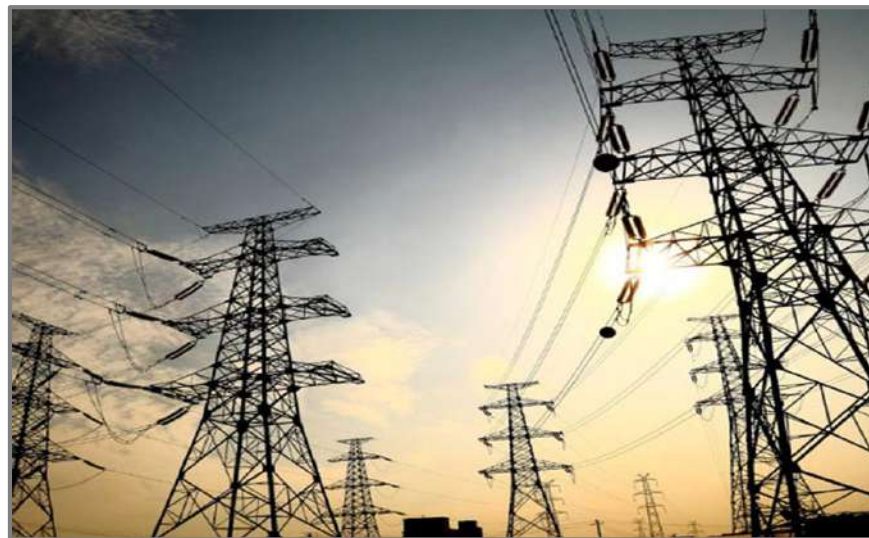
Imagen N° 10. Torres de Transmisión
