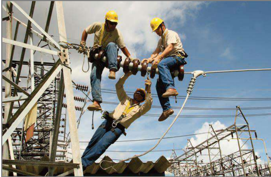
Imagen N° 11. Inspección en líneas de transmisión
