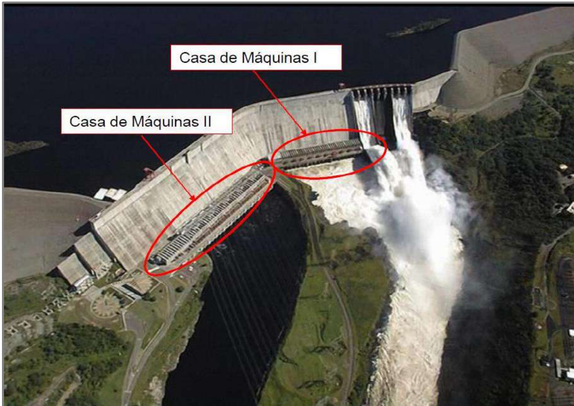
Imagen N° 5. Casas de Máquinas de Guri
